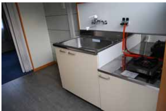
仮設住宅 キッチン
