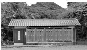
▼岩屋寺駐車場の多目的トイレ
