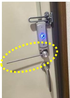
玄関の自動ドアです。実は5年の間に2回ドアが壊れました。1回目は猛暑でセンサーが反応しなくなりました。2回目は、家の近くにカミナリが落ちて、ドアが動かなくなりました。2回目のドアの修理のときに、業者さんが小さいおたまのような補助具をつけてくれました。センサーの下にある物が補助具です。自動ドアの故障のとき、補助具の取っ手を下げながらドアを押すと、ドアが開きます。
