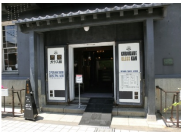
黒壁1号館 入口にスロープ設置
