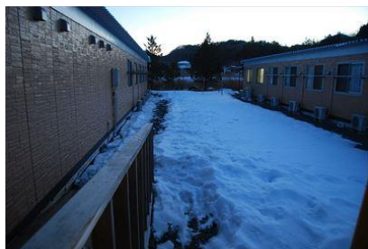
入居者38名がグループホーム型の仮施設2棟（男子棟、女子棟）に引越
