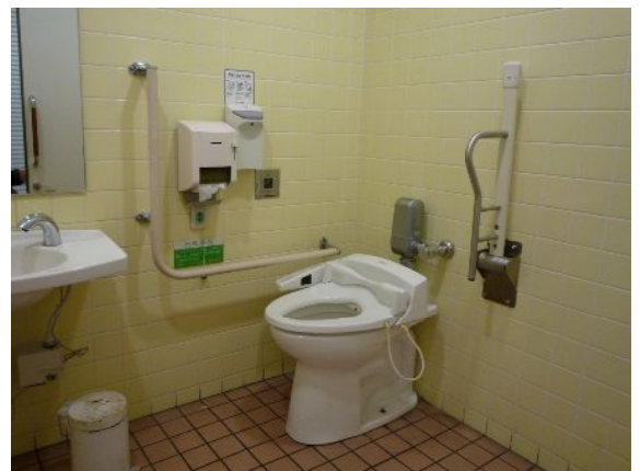
1階の多目的トイレ
