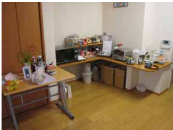
造り付けカウンター(左に造り付け物入)
