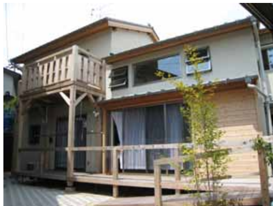
建物の南側外観(右にスロープが見える)
