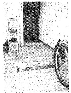
玄関（段差解消機が上がった状態）
