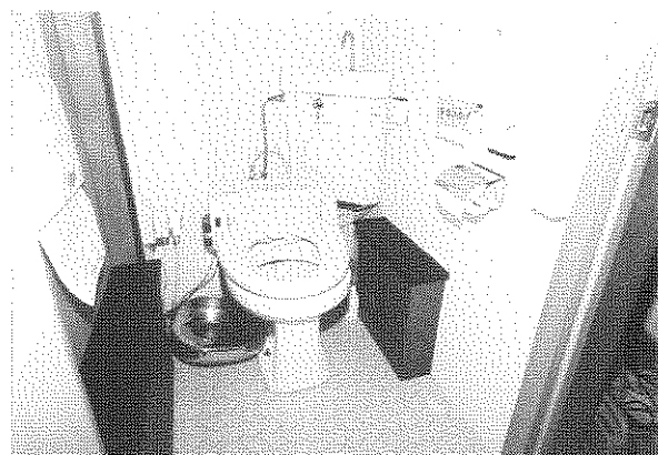
トイレ(左側に見えるのが元のドア。左右にある黒い台が手すり台)
