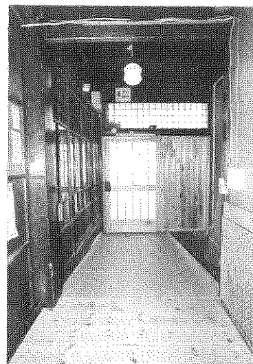
玄関からスロープを見る
